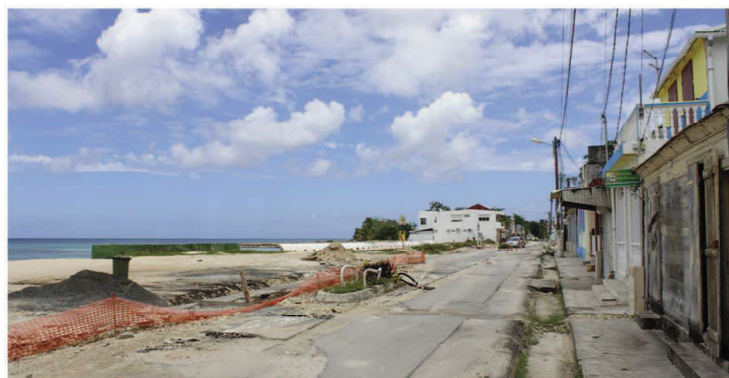
Chantier d'enfouissement à Port-Louis
