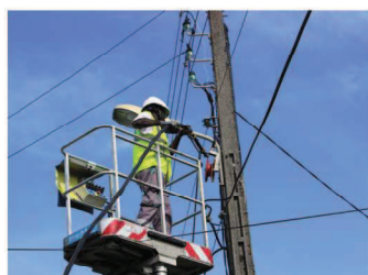
Pose de câble torsadé / Saint-Claude
