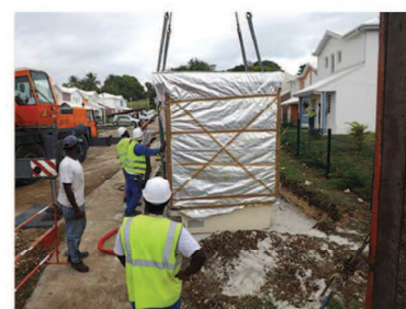
Pose d'un poste cabine / Petit-Bourg
